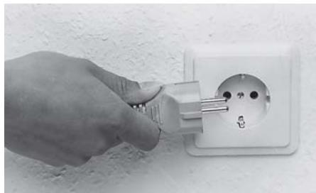
**Warnung:** Netzstecker nur außerhalb explosionsgefährdeter Bereiche mit der Stromversorgung verbinden bzw. trennen.
